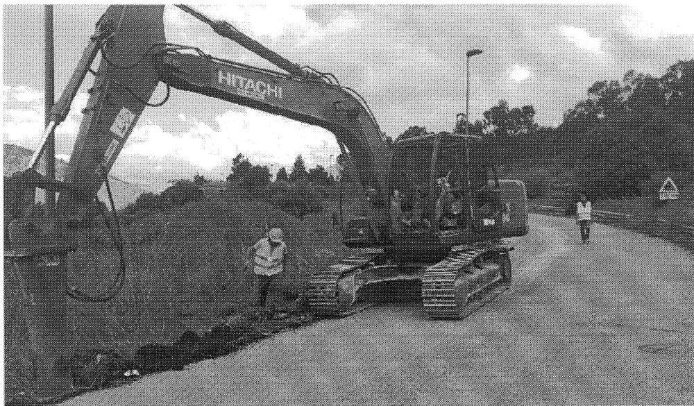
I lavori per la realizzazione della bretella alternativa all'autostrada Palermo-Catania
